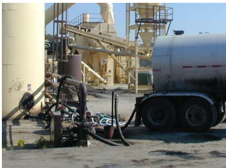
Rysunek 20 – Cysterna z emulsją Evotherm podłączona do instalacji pompowania asfaltu WMB.
