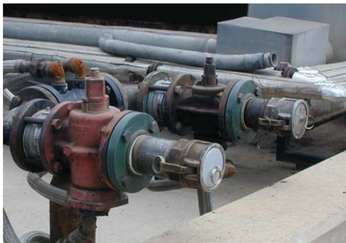
Rysunek 19 – Zawory służące do przyłączenia cysterny z Evothermem.
